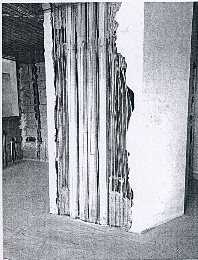
شکل ۱۰- تخریب دیوارها جهت عبور لوله های تاسیساتی
